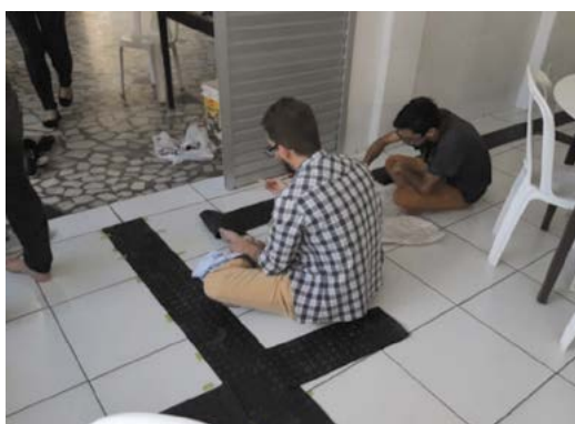
Figura 24 – Mutirão dos alunos para colocação de piso podotátil
